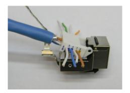
• Cat.6-Buchse mit eingelegter Schneid-Klemm-Form im Schraubstock einspannen und zusammenpressen
